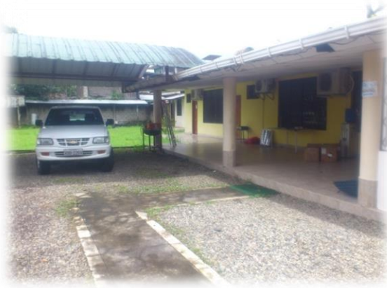
Ilustración 1 Ingreso al Laboratorio
