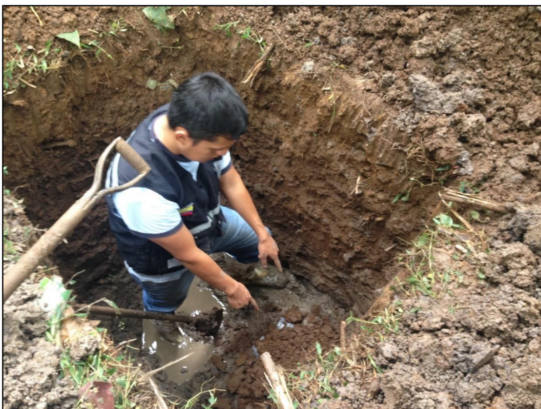
Figura 20-3 Apique en la cresta del talud
