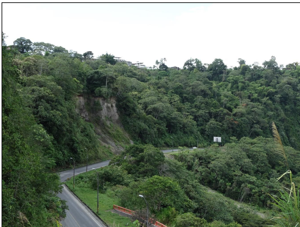
Figura 2-1 Acceso al deslizamiento
