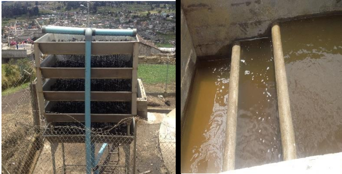
Tanque salida filtros de carbono- Sector Pie de Pucara
