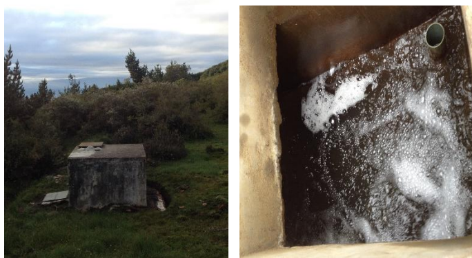
Tanque de llegada después de recorrer 20 Km desde la vertiente – Sector Chuzalongo
