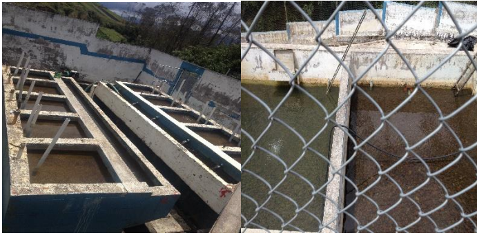
Tanque antes y después de los filtros de arena – Sector Colacucho
