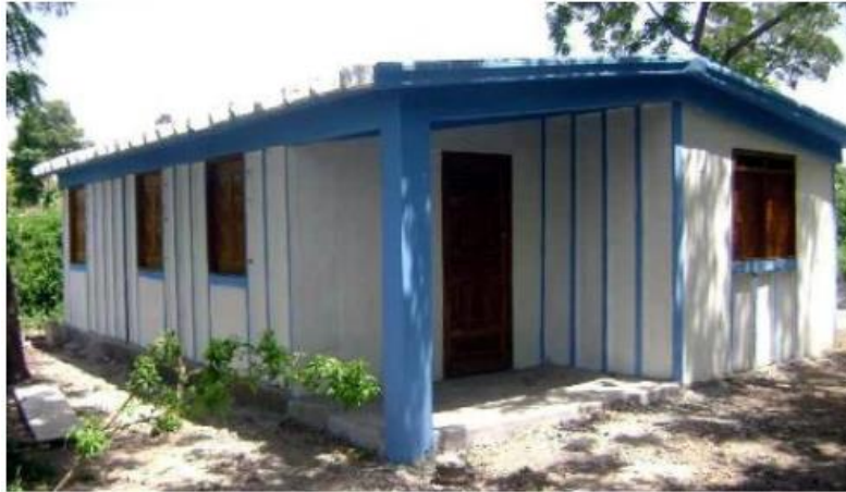
Figura 14: Construcción con paneles de ferrocemento Fuente: http://www.ecosur.org . Consultado 2016.
