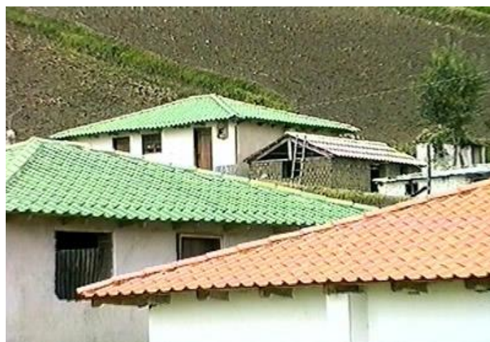
Figura 33-15: Tejas de microconcreto. Ecuador Fuente: http://www.ecosur.org . Consultado 2016.
