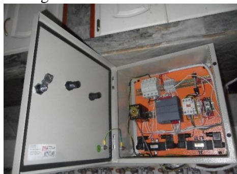
Figura 36. Tablero de control
