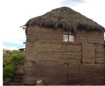
Casa típica Puruway (Zona de Balda Lupaxi) FOTO N36: Baltazar Pasa
