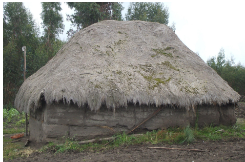
Casa Puruway (Zona Calshipoguio) FOTO N37: Diana Paredes y Santiago Flores
