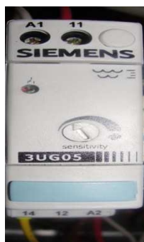
Figura II.3: Relé de supervisión SIEMENS 3UG05 02-2AF00
