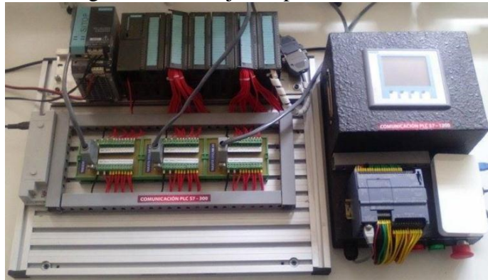
Figura 49. Montaje del panel de control
