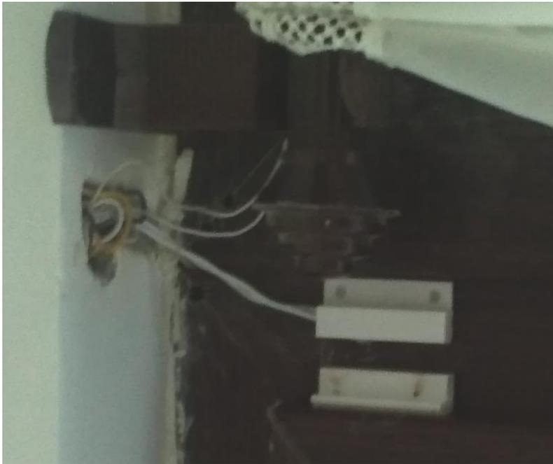
**Figura 2-26** Colocación de sensores magnéticos en las ventanas y puertas
