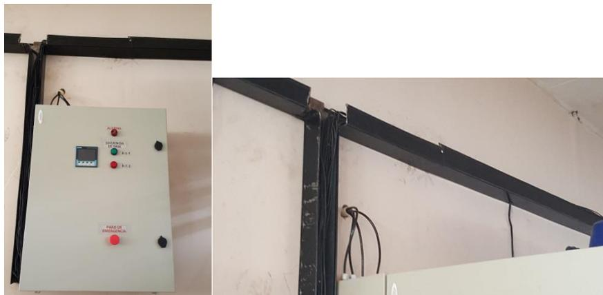
**Figura 29-2 Cableado desde el Tablero hacia los Equipos**
