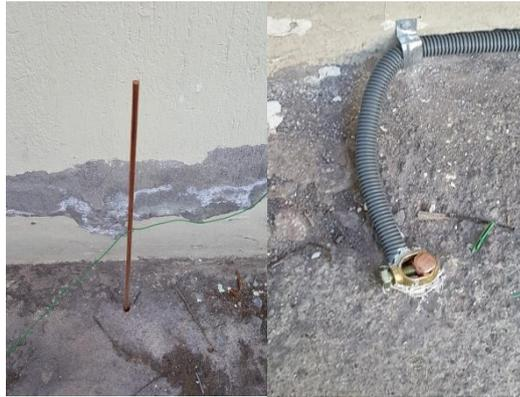
**Figura 30-2** Instalación de la Varilla de Puesta a Tierra
