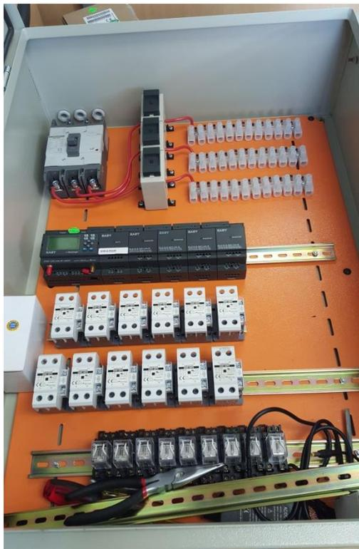
**Figura 20-2 Distribución de Riel DIN y Elementos**
