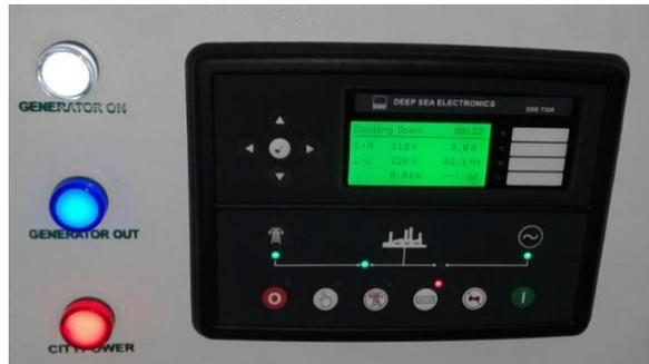
**Figura 12-3:** Finalización del proceso de transferencia
