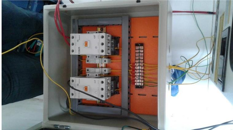
**Figura 5-3:** Conexión del circuito de fuerza con el de control
