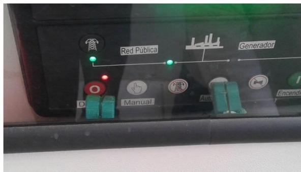
**Figura 17-3:** Pulsación del botón de arranque del generador
