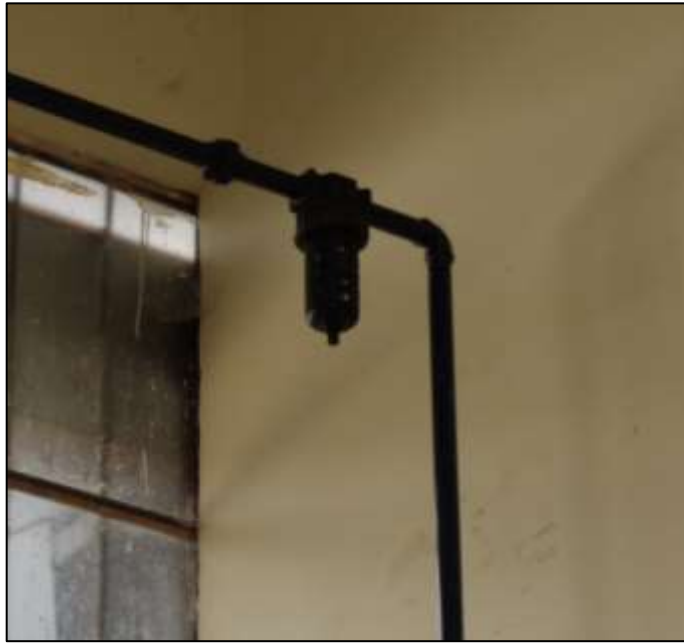
Figura 29. Filtro de aire
