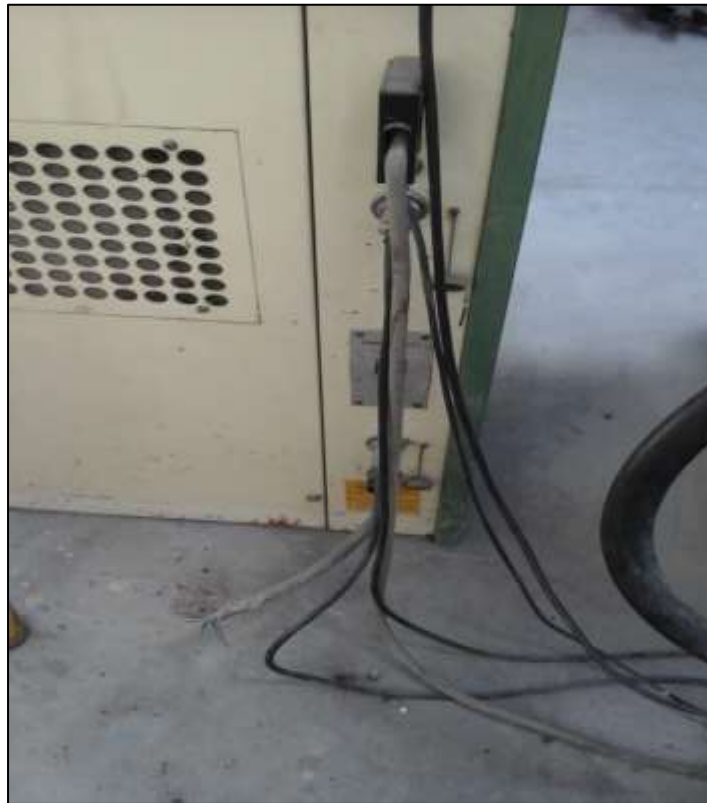
Figura 15. Instalación eléctrica inexistente
