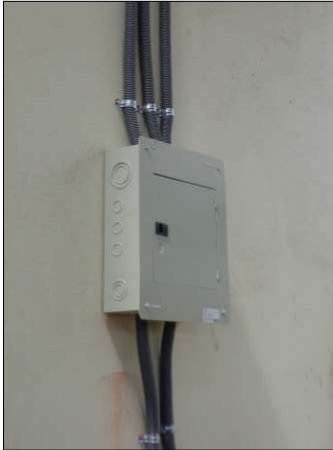
Figura 23. Caja de protección general
