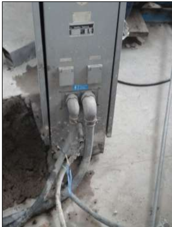
Figura 26. Instalación eléctrica averiada
