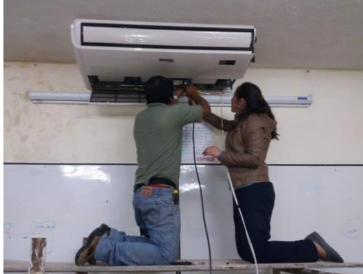
Figura 32. Comprobación del desague
