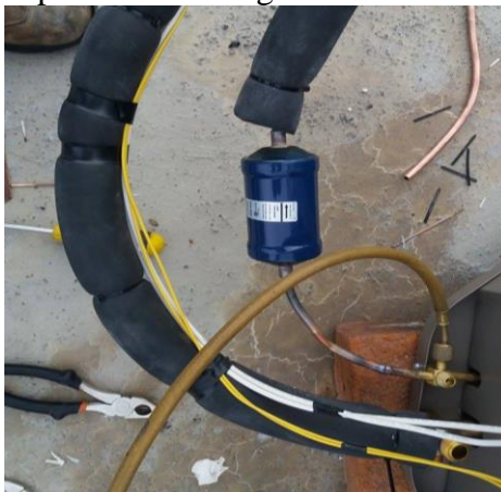
Figura 31. Comprobación de fugas del sistema de refrigeración
