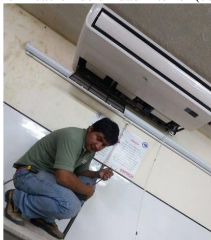
Figura 36. Verificación de unidad interior (condensadora)
