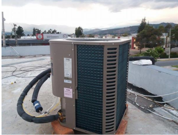
Figura 37. Verificación de unidad exterior
