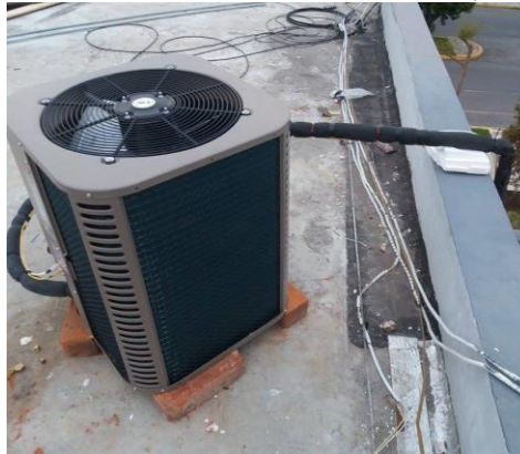
Figura 33. Verificación de la cubierta de rubatex (aislamiento térmico)
