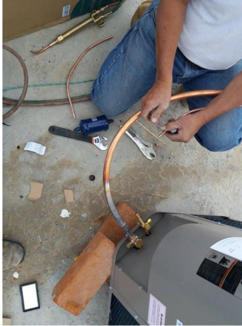
Figura 35. Verificación de longitud de tubos de refrigeración y carga de refrigerante
