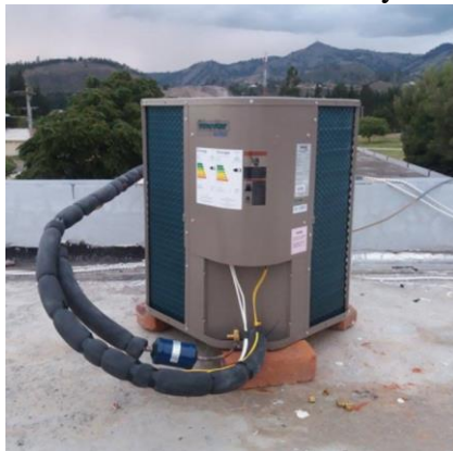
Figura 30. Colocación de tubos de cobre y cableado eléctrico
