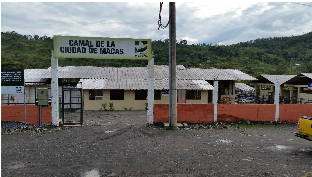
Fotografía 1-2 Instalaciones del Camal Municipal de la Ciudad de Macas
