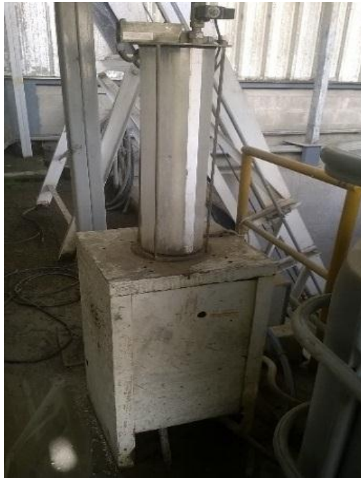
Figura 3-8 Bomba de aditivo Fuente: EPCE.
