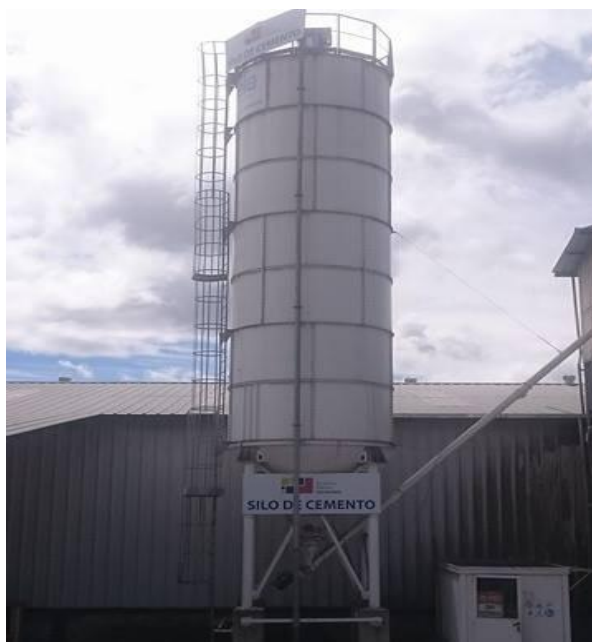
Figura 3-7 Silo de cemento. Fuente: EPCE.
