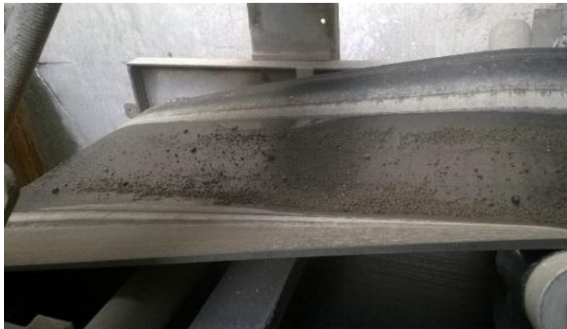
Figura 3-4 Banda transportadora (arena, ripio). Fuente: EPCE.
