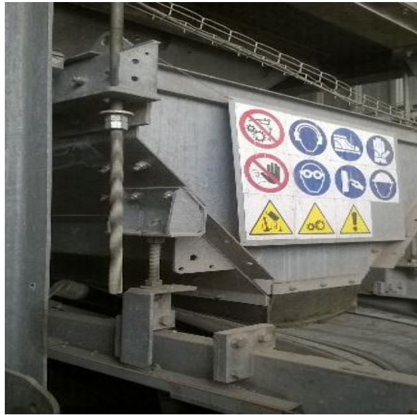
Figura 3-3 Tolva de agregados (arena, ripio) Fuente: EPCE.
