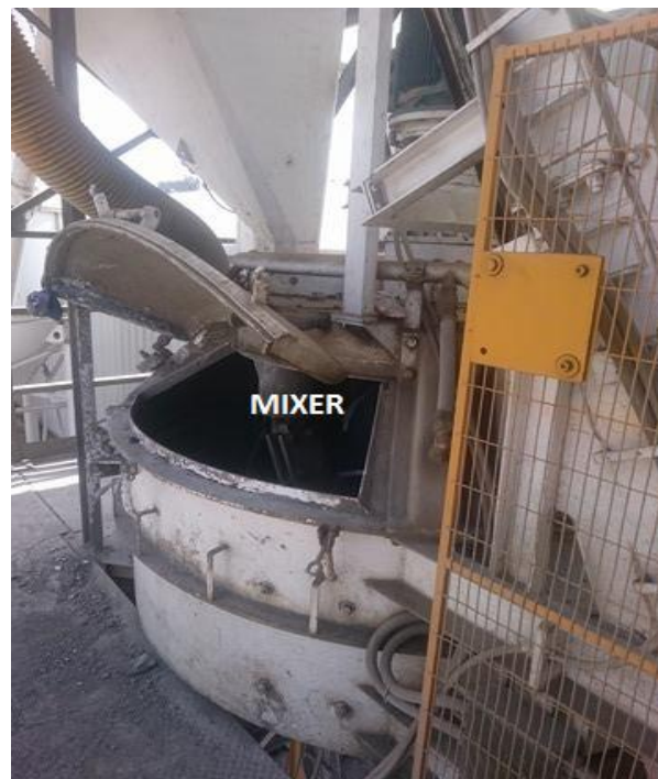
Figura 3-6 Mezcladora (arena, ripio, cemento, agua y aditivo). Fuente: EPCE.
