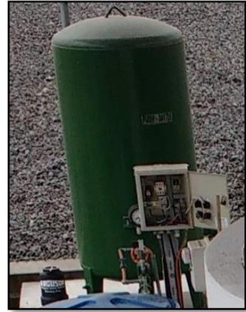
**Fotografía 8.** Tanque Hidromeumático
