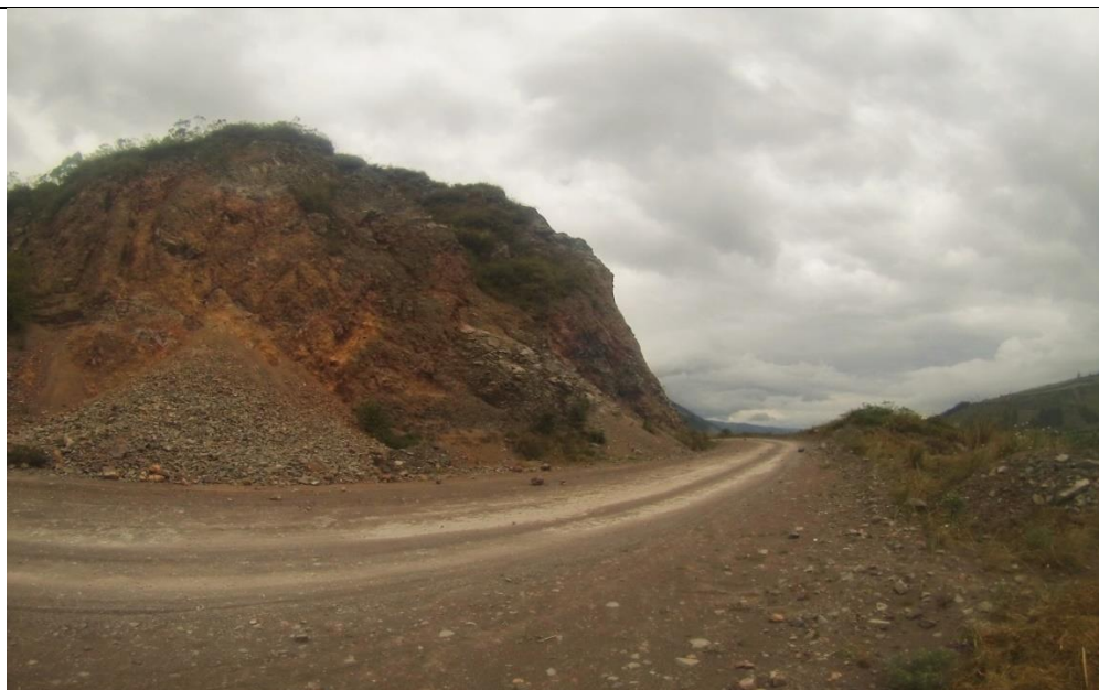
FIGURA 51 Afloramiento de material volcánico en la vía Guanando - Cahuají
