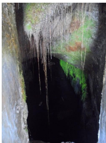
FIGURA 54 Socavón u ojo de agua Fuente: Autor
