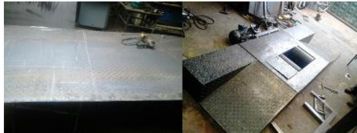
Figura 63. Cubierta de la estructura.
