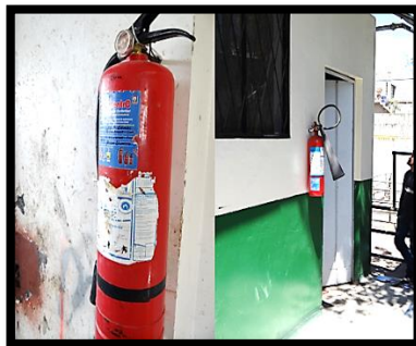
Figura 21. Estado actual de extintores en el camal
