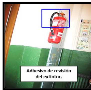
Figura 50. Revisión del extintor
