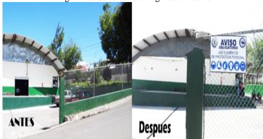
Figura 40. Señalética al ingreso del camal
