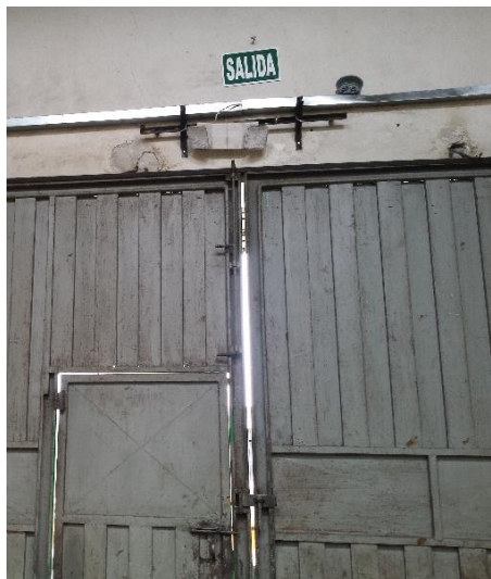
Figura 17. Sirena de emergencia
