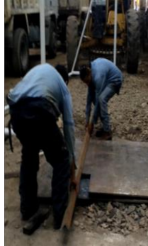
Figura 30. Puesto de soldadura – columna flexionada
