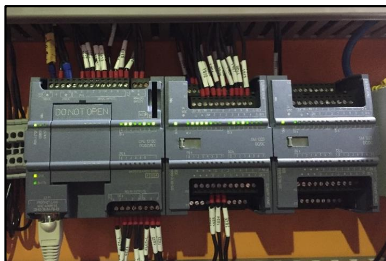
Figura 6-2: PLC SIEMENS. Realizado por: Villacrés M. 2017.
