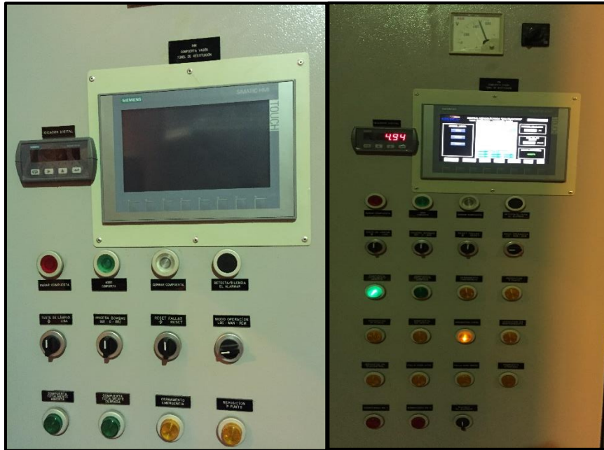
Figura 16-3: Pantalla touch SIEMENS instalado en el tablero de control. Realizado por: Villacrés M. 2017.
