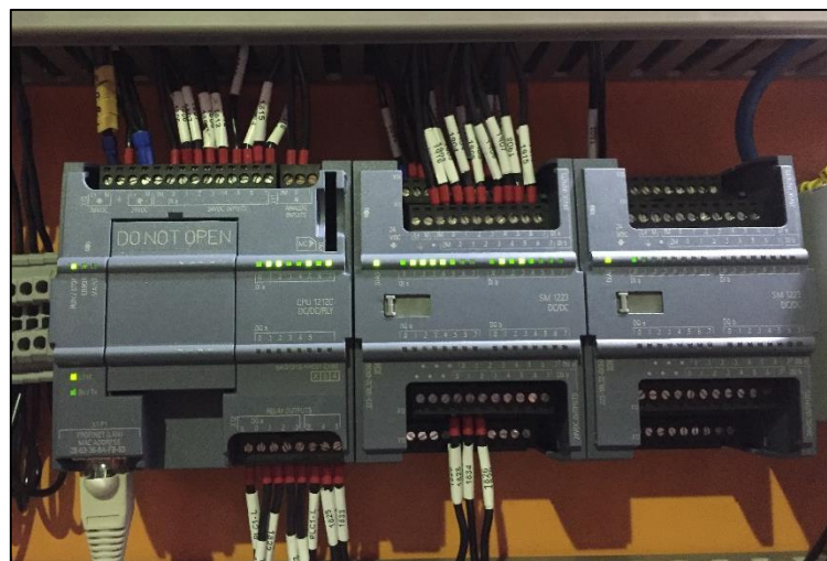
Figura 15-3: PLC instalado para el nuevo sistema de control. Realizado por: Villacrés M. 2017.
