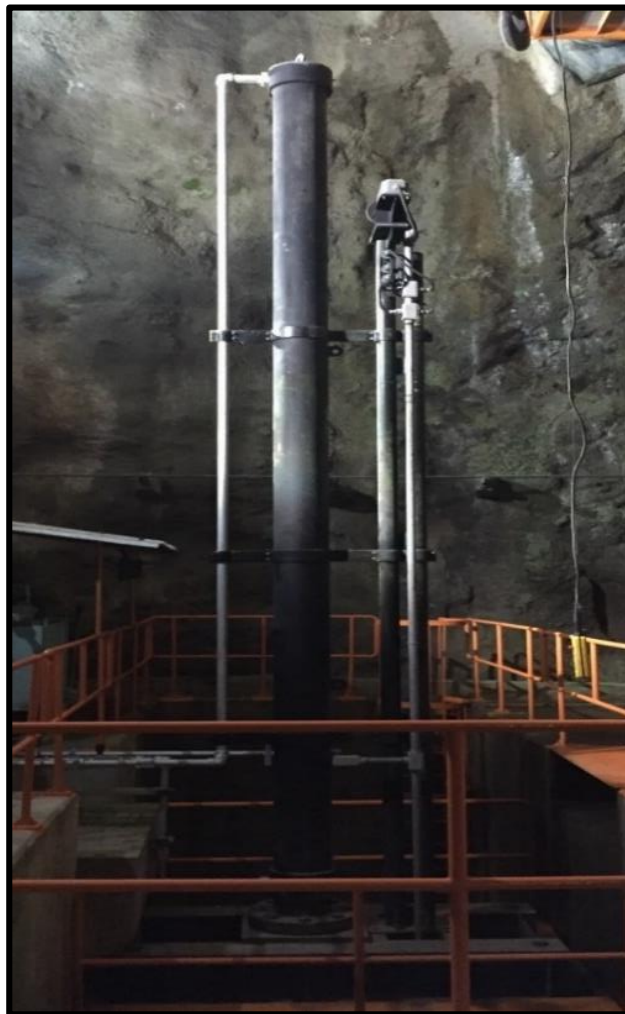
Figura 1-2: Compuerta vagón Central "San Francisco" Realizado por: Villacrés M. 2017.
