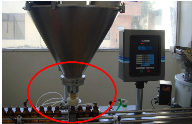
FOTOGRAFÍA No. 3. PUNTO CRITICO, TOLVA PARTE INFERIOR
