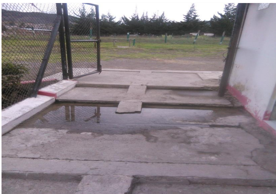
Fotografía 12. Ingreso a los corrales de engorde, y sala de maternidad.
