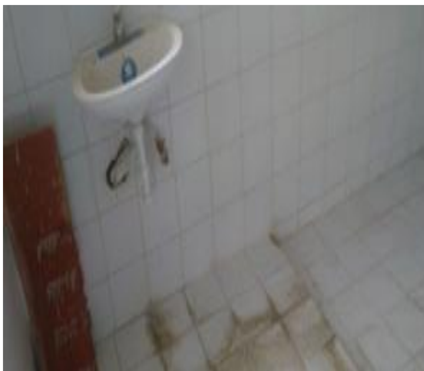
Fotografía 10. Área de baños y ducha del plantel porcícola de la Facultad de Ciencias Pecuarias de la Escuela Superior Politécnica de Chimborazo.
