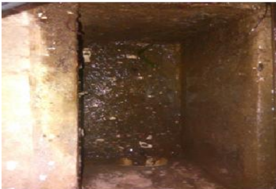
Fotografía 5. Drenaje y acumulación de las aguas residuales.
