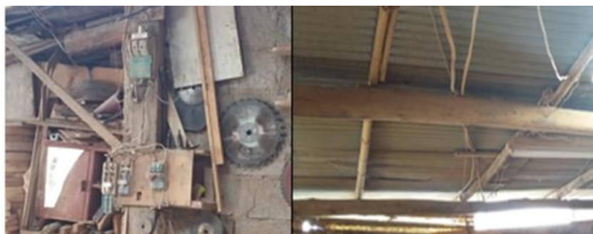
Figura 6-3: Palancas de activación y cableado situación inicial Realizado por: Jhonatan Machado
