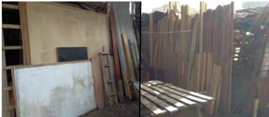
Figura 11-3: Almacenaje de tableros y de tablones Realizado por: Jhonatan Machado
