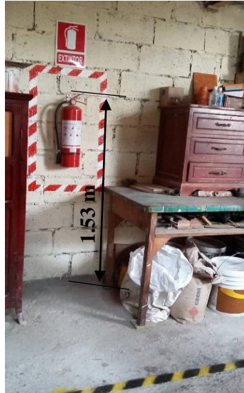
Figura 15-4: Implementación del extintor Realizado por: Jhonatan Machado
