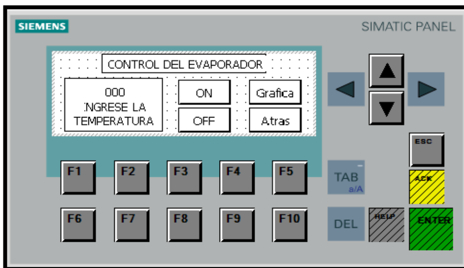
Figura 37-2: Pantalla Evaporador Eléctrico Realizado por: Infante y Aldaz, 2017
