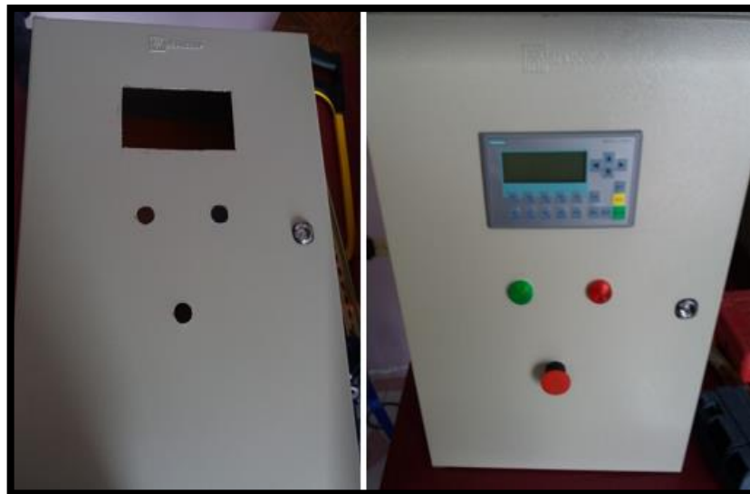
Figura 20-2: Tablero de control Realizado por: Infante y Aldaz, 2017
