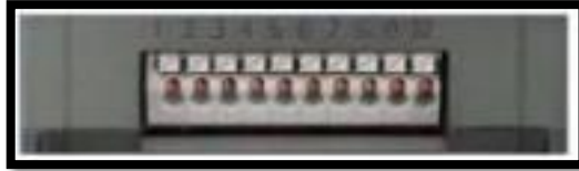
Figura 40-2: Bornera del variador de frecuencia Realizado por: Infante y Aldaz, 2017
