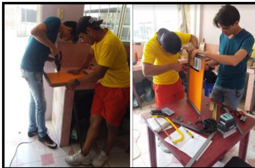
Figura 16-2: Montaje de la Sección 1 Realizado por: Infante y Aldaz, 2017
