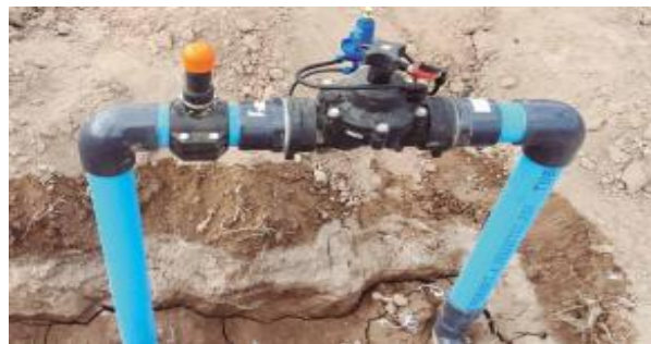
Figura 15-1. Cabezal de campo con válvulas hidráulicas instaladas Fuente: (Liotta, 2015).
