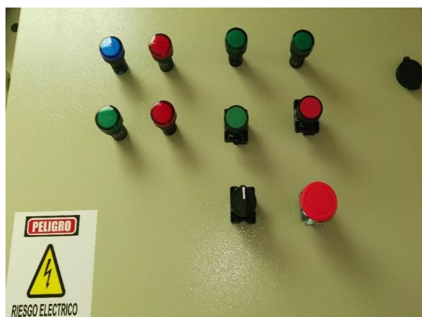
Figura 18-2. Elementos de Señalización y activación Fuente: Kleber Chulde, 2017
