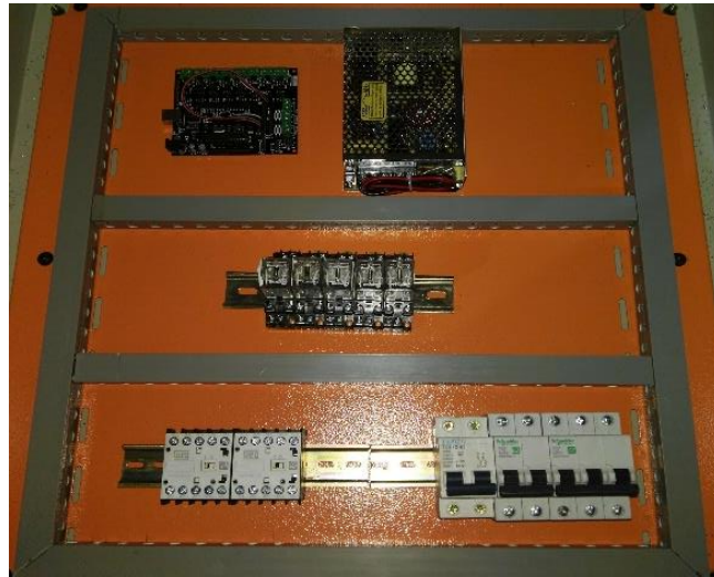
Figura 17- 2: Distribución de canaletas y carril Din Realizado por: Kleber Chulde, 2017
