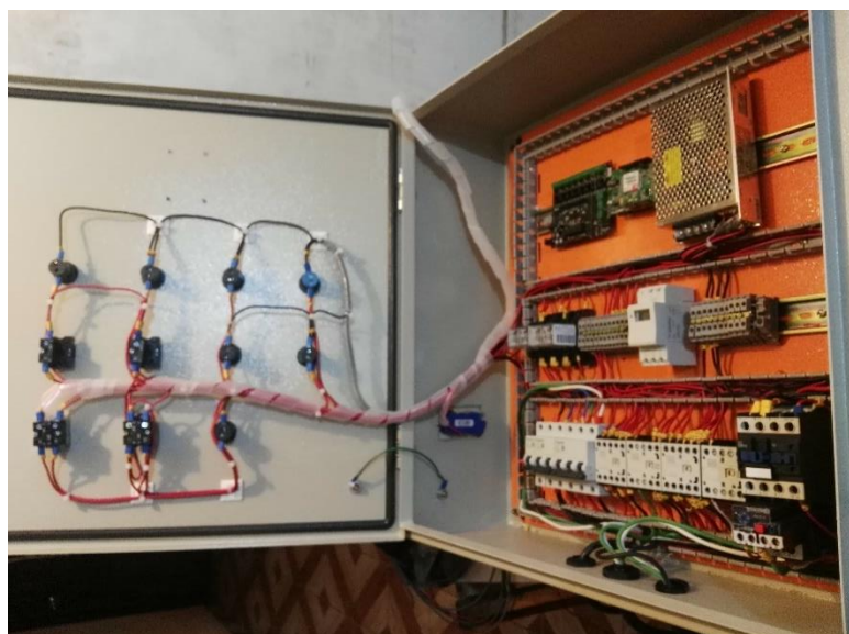
Figura 22-2. Vista interior del tablero Realizado por: Kleber Chulde, 2017
