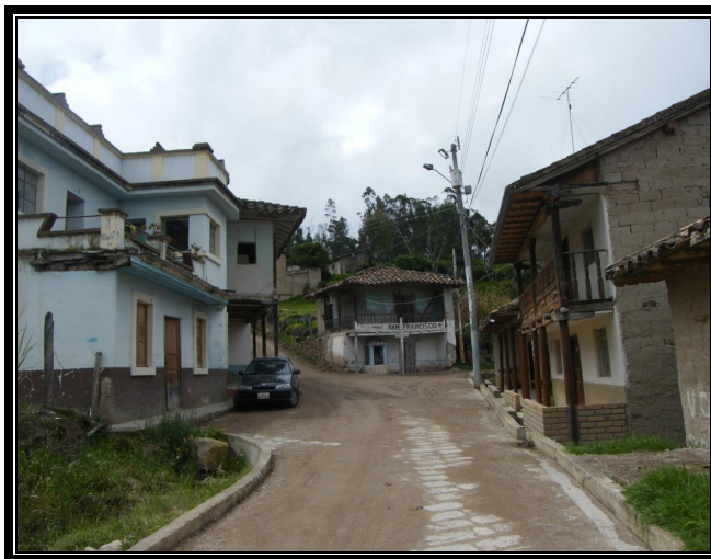
Fotografía N° 26. Arquitectura del cantón Oña
