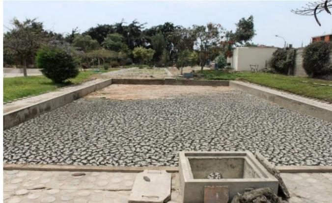
**Figura 10-3.** Esquema de un Lecho de secado
