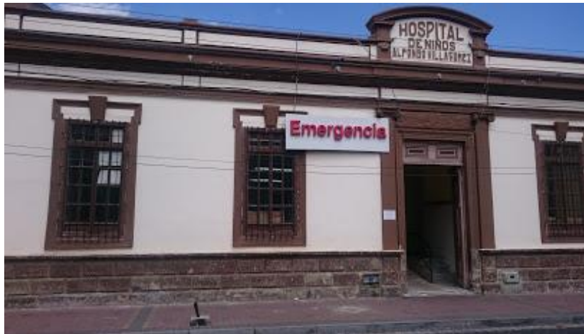
Gráfico 3-3. Edificio Hospital Pediátrico Alfonso Villagómez Román Fuente: Google Maps
