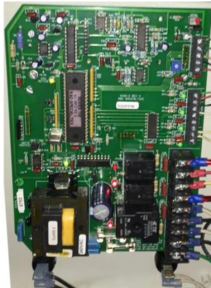
Figura 3-8 Placa Electrónica Planta Purificadora 2 Fuente: Autores
