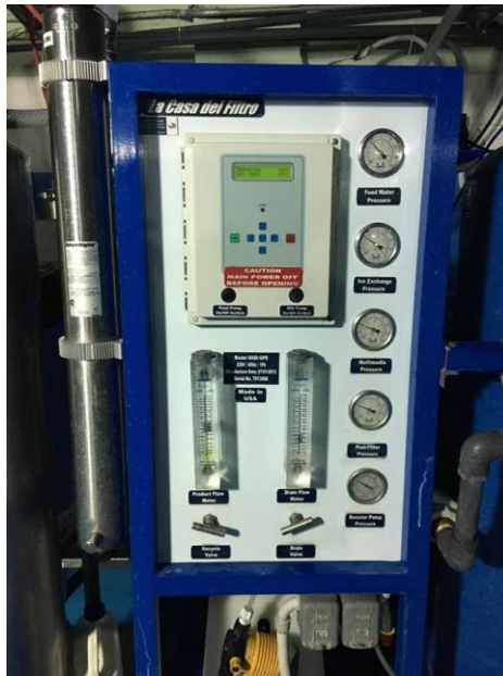
Figura 3-7 Tablero de control y mando Planta Purificadora 2 Fuente: Autores
