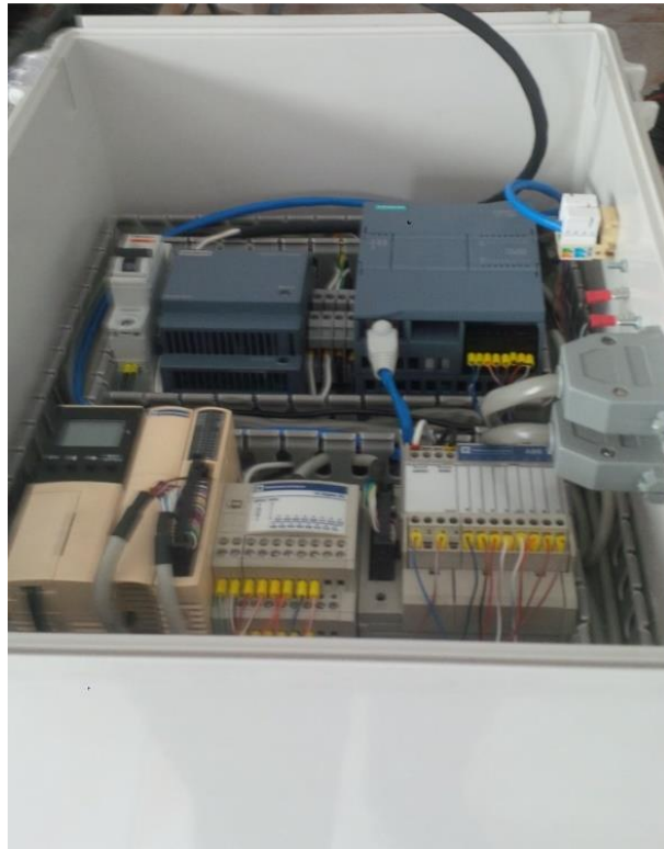
Figura 3-3 Conexión de equipos módulo. Fuente: (Autores, 2017)
