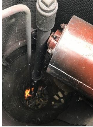
Figura 59-3: Dosificación de biomasa forestal
