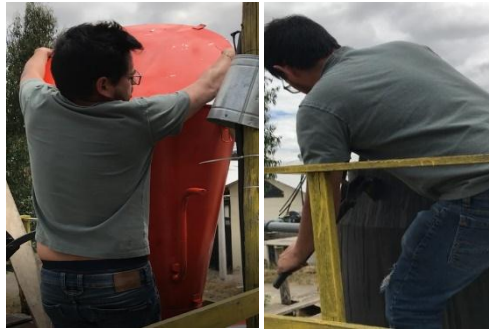
Figura 60-3: Cerrado hermético de la tapa superior
