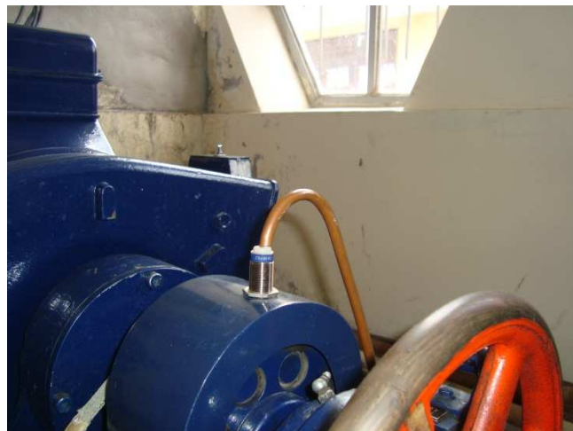
Figura 5.31 Sensor de proximidad ubicado en la bomba axial.
