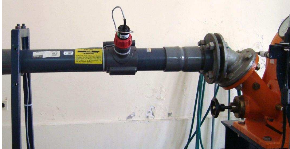
Figura 5.26 Sensor de flujo auto alimentado ubicado en la turbina Pelton.
