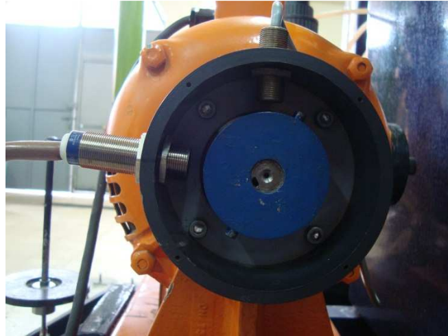
Figura 5.30 En las fotografías se muestra el sensor de proximidad instalado en la bomba centrífuga.
