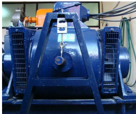
Figura 5.39 Celda de carga en la bomba axial
