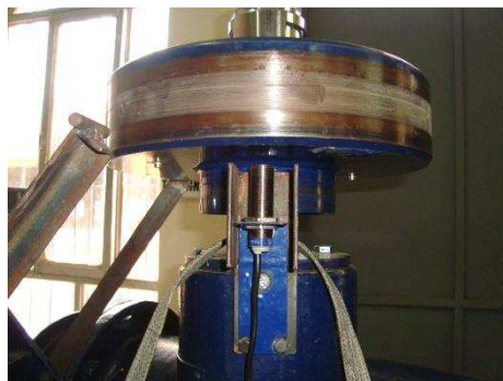
Figura 5.34 Sensor de proximidad instalado en el tambor de freno de la turbina Kaplan.
