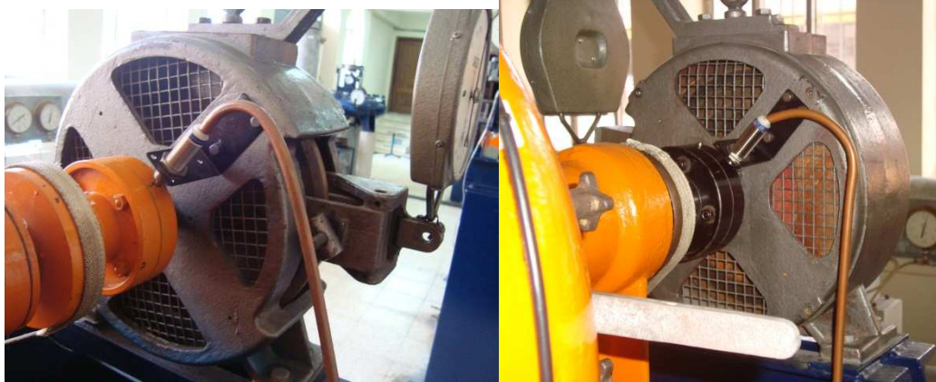
Figura 5.32 Sensor de proximidad turbina Pelton.
