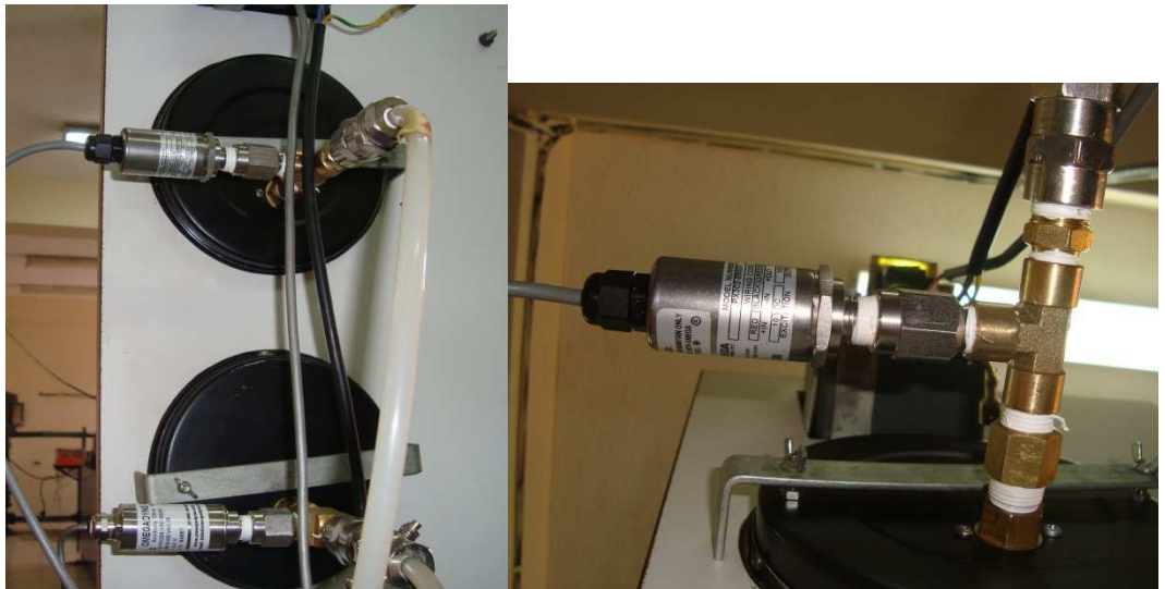
Figura 5.11 Montaje de los transductores de presión.
