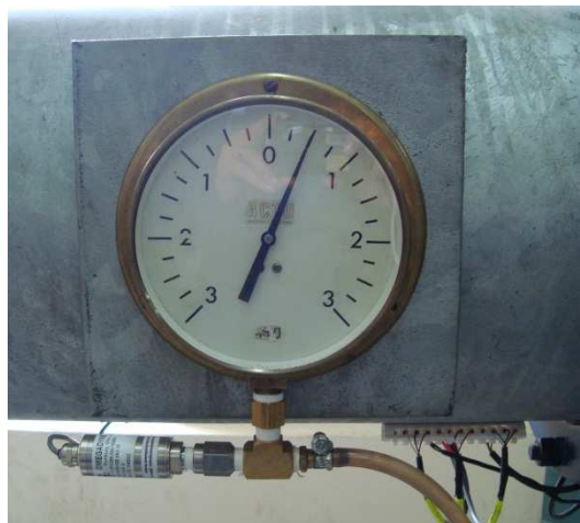
Figura 5.15 Manómetro y transductor de presión de rango compuesto, ubicados en la descarga de la turbina Kaplan.
