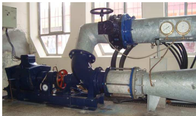
Figura 5.3 Fotografía del banco de pruebas de la bomba axial.
