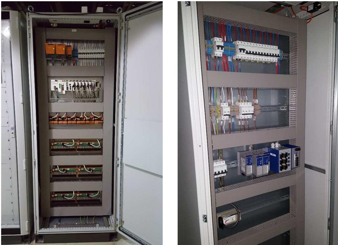
**Fotografía 2-3: Vista frontal y posterior de tablero de la UAC.**
