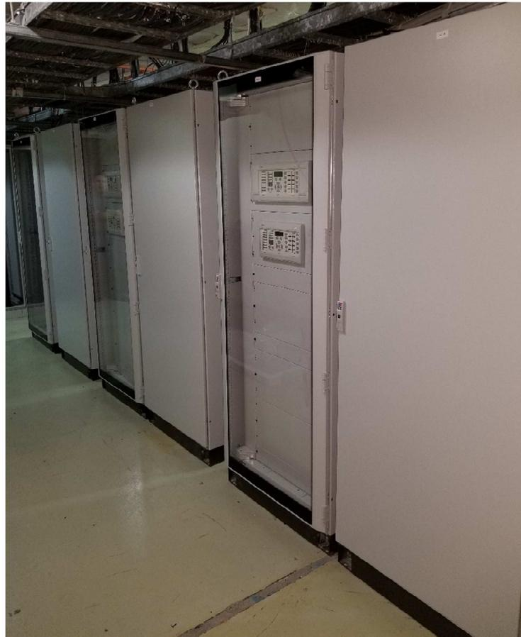
**Fotografía 1-3: Tableros para el control de las unidades de generación.**
