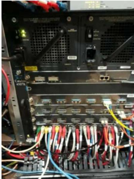
**Figura 3-2:** Fotografía del Switch de Core Cisco Catalyst 4507R - EERSA
