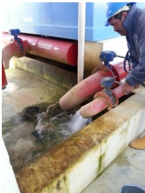
**Fotografía 2-1:** Descarga de lodos al sistema de desagüe
