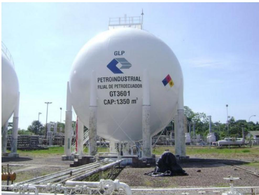
**Figura 10-3.** Tanque Esférico para Almacenamiento de GLP.
