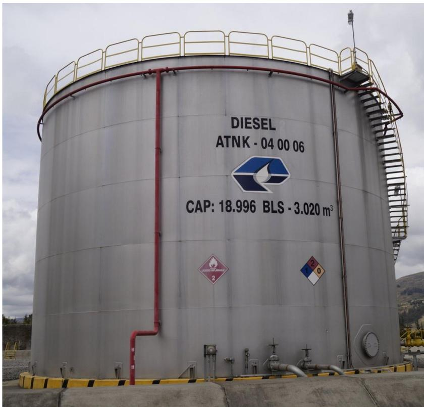
**Figura 9-3.** Tanque Vertical de Techo Flotante.
