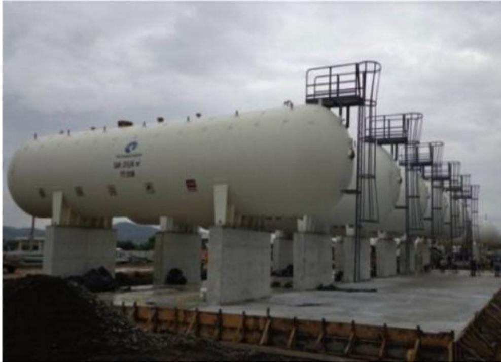
**Figura 7-3.** Tanques Horizontales, Proceso de Licuefacción de GLP.
