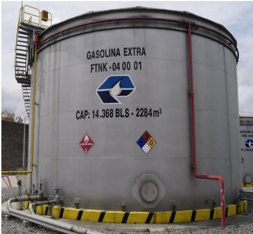
**Figura 8-3.** Tanque Vertical de Techo Fijo.
