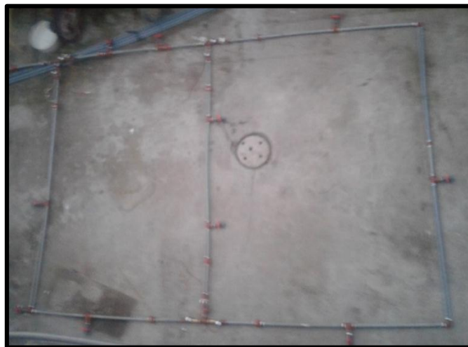
Figura 5-3: Fotografía de la red local de agua potable Realizado por : GUAÑO Wilmer, 2017
