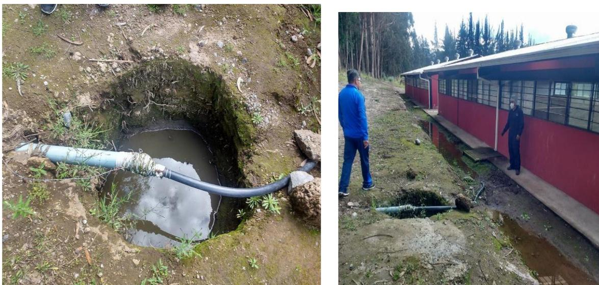
Fotografía 10. Presencia de grietas y tubería en mal estado.
