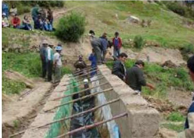
**Fotografía 2-1:** Ubicación del digestor en zanja protegida con tapiales de adobe
