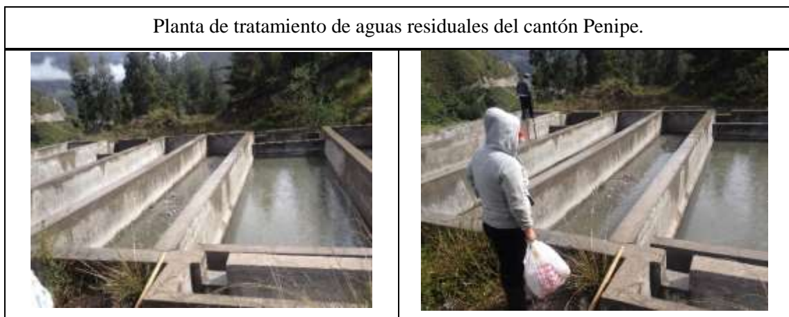
Gráfico 2-2: Planta de tratamiento de aguas residuales de la cabecera cantonal del cantón Penipe.
