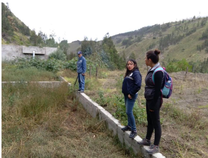
Fotografía 1A. Inspección de la planta de tratamiento de aguas residuales Penipe.
