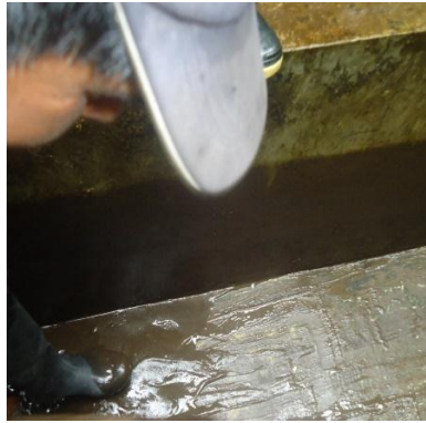
Sedimento lodoso en el tanque de captación de la vertiente 1
