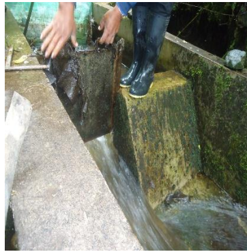
Paredes de los tanques de captación
