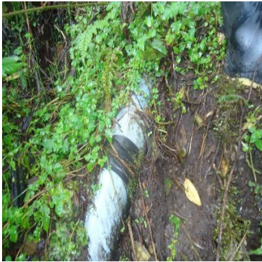
Tuberías en mal estado
