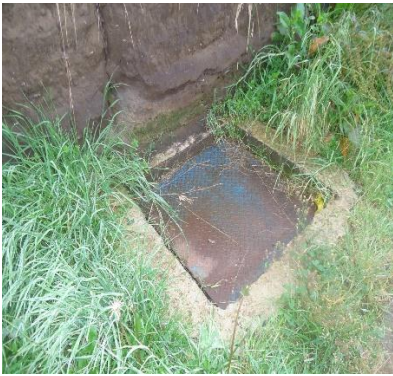
Estado de los tanques de almacenamiento
