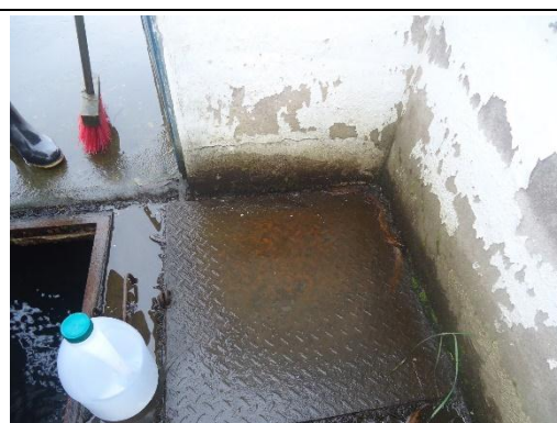
Fotografía 8. Tanque de reserva de la parroquia Quimiag
