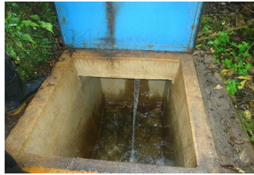
Fotografía 2. Tanque de captación Quebrada Paquisha
