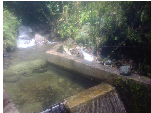
Fotografía 4. Zona de retención de agua de la vertiente de la Quebrada Sananquillay
