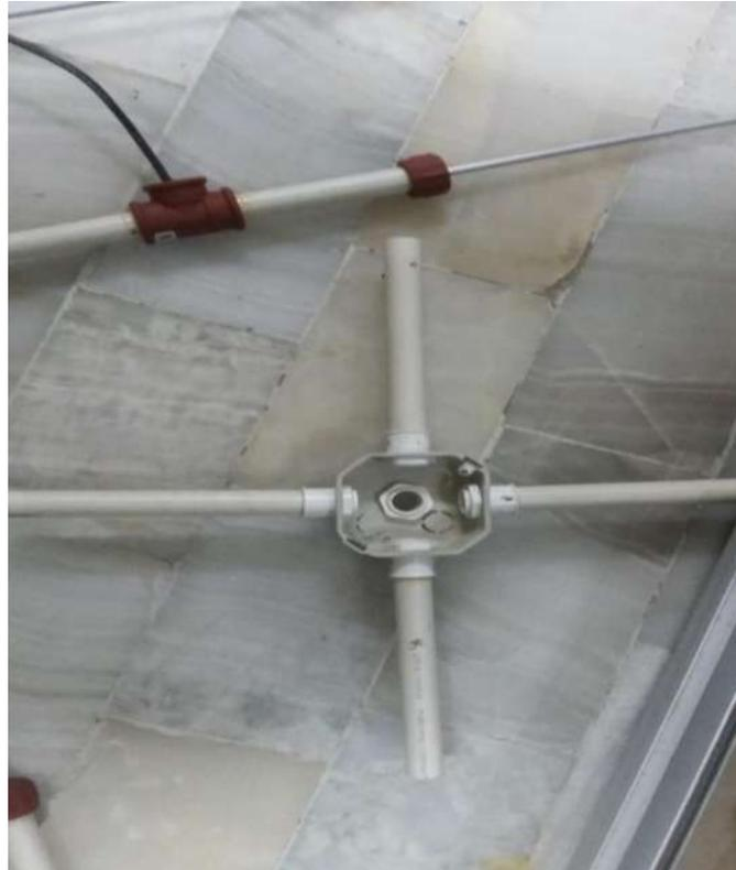
**Ensamblado de los tubos de PVC para formar la estructura de la antena**
