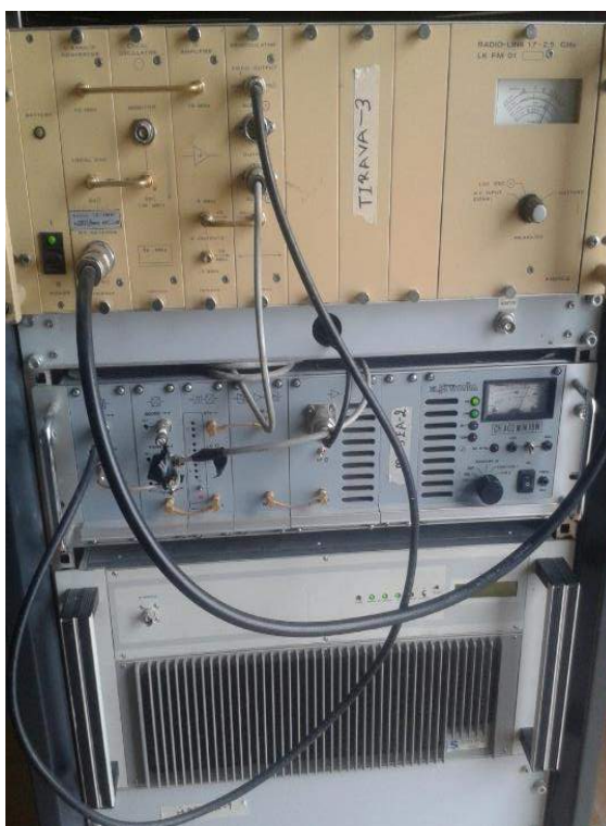
Figura 11-3: Equipos de recepción y transmisión en cerro Pilisurco.
