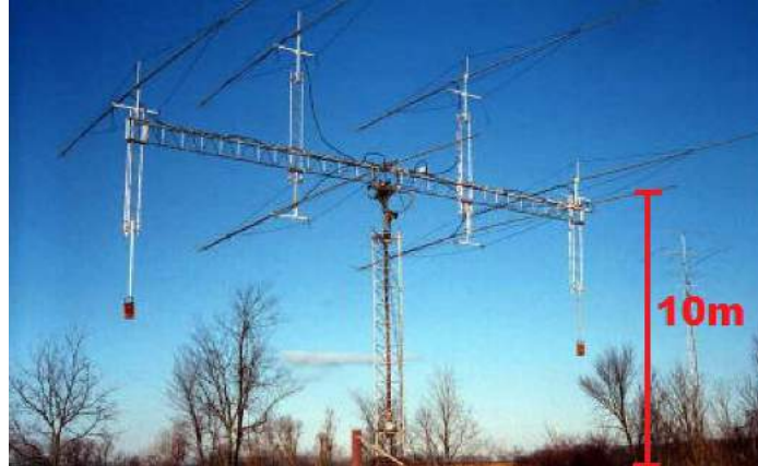
Figura 8-1: Antenas directivas a 10m del suelo
