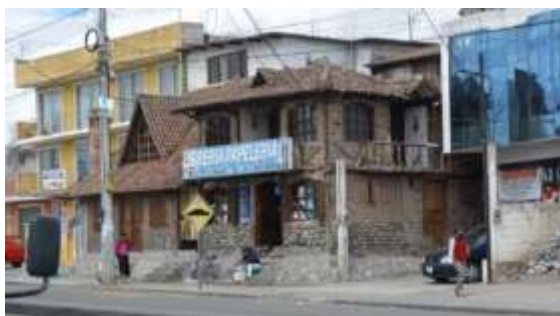
Figura 8-1: Edificaciones actuales en Salasaka
