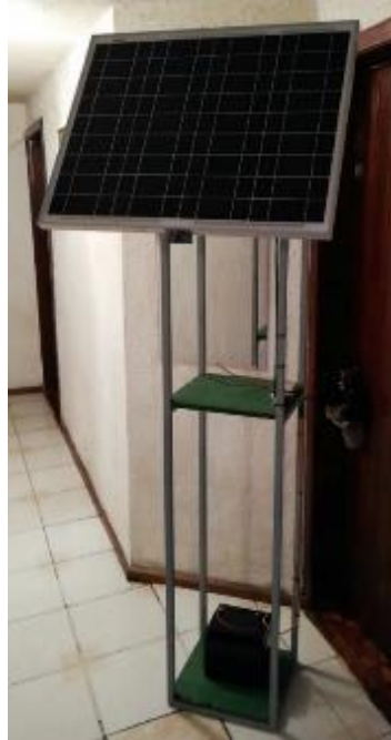
Figura 8-3: Sistema Fotovoltaico ensamblado
