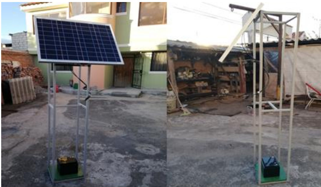
Figura 6-3: Montaje panel y batería
