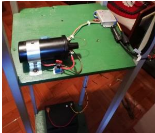
Figura 10-3 Generador de alto voltaje instalado.
