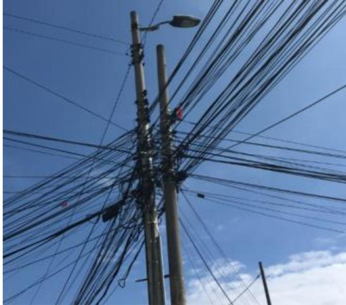
**Figura 1-5:** Cable en postes de alumbrado sin identificación. Norte de Quito
