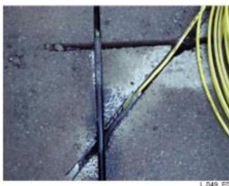
**Figura 24-2** Microzanjado con técnica para cambio de dirección
