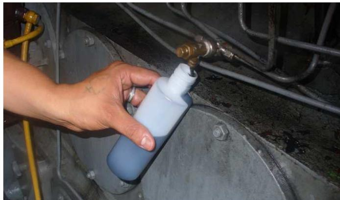
**Figura 2.10:** Método del Grifo o Llave Purgadora
